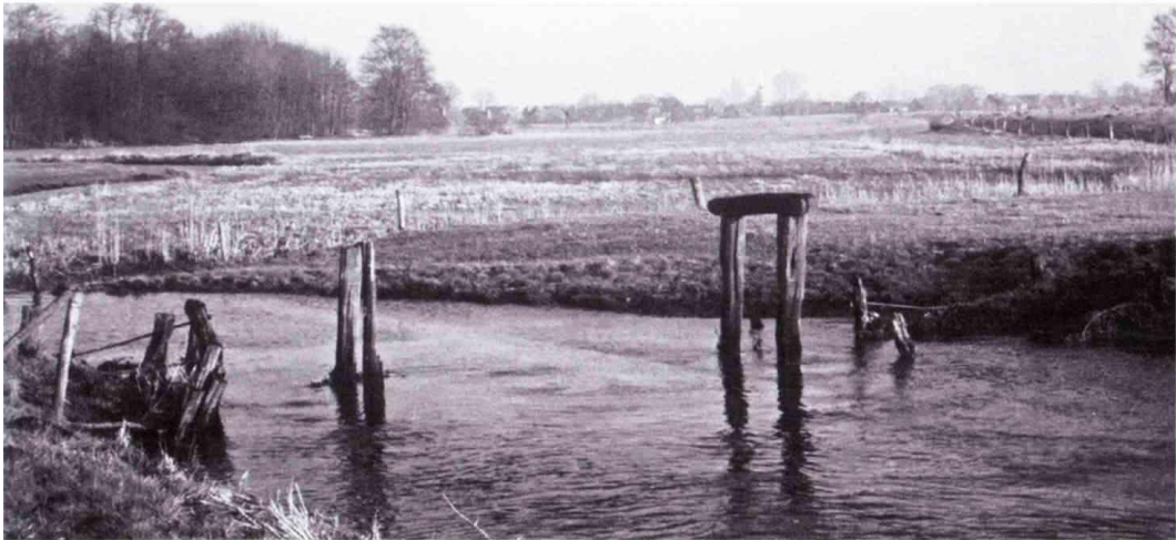
De restanten van het voetvonder die nog lange tijd te zien waren achter Dickninge.
